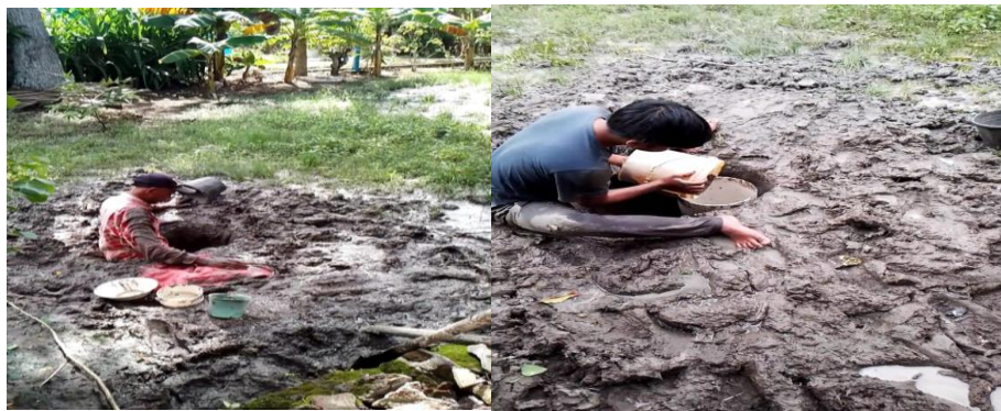
Gambar 5. Proses Penggalian Tanah dan Pemasangan Lubang Biopori
